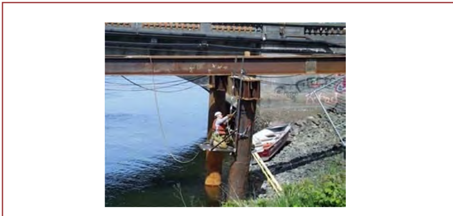
شکل ۵۱- کارگری که به طور همزمان از PFD، حفاظ چشم، حفاظ دست و حفاظ سر در حین جوشکاری، استفاده می کند
